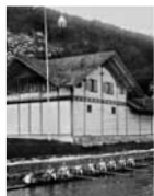
Beim Kauf eines Achters musste das Bootshaus um 4 Meter verlängert werden, die Tore wurden von der West- auf die Ostseite verlegt.
